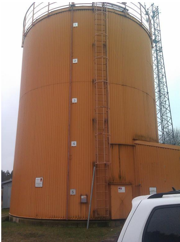
Figur 2: Här är en bild på oljecisternen i Ljungsbro. Tanken är på 500m 3 med 8 meter i diameter och 10 meter i höjd.
